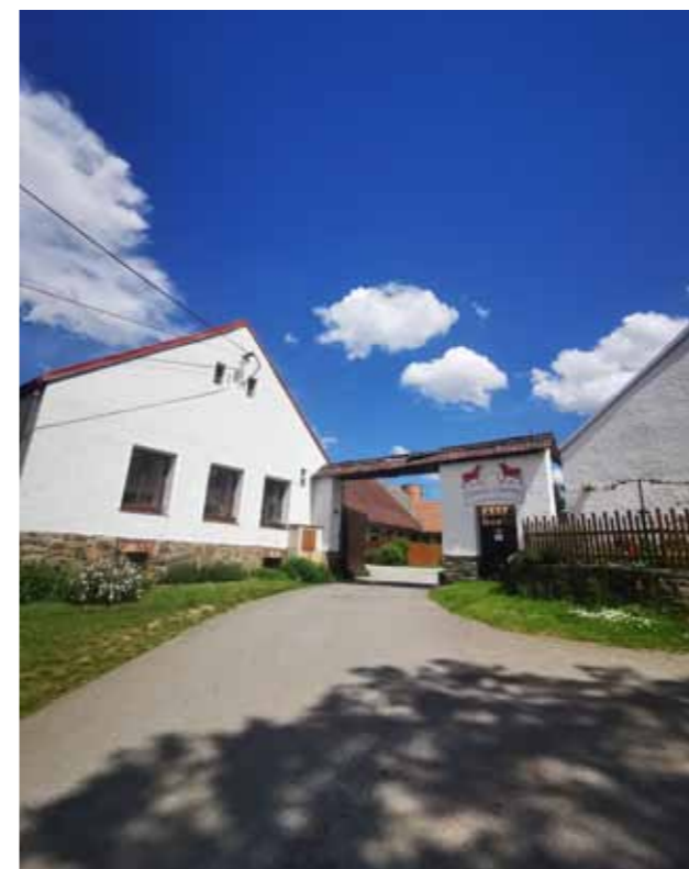
Palečkovi převzali statek ve velmi zanedbaném stavu, vyžadoval spoustu investic do rekonstrukcí.
